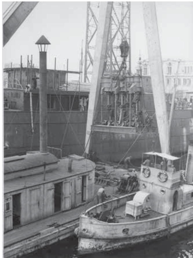
Cabra Esperanza y remolcador Setantí en la instal·lació d'una màquina de vapor. Foto: Museu Marítim de Barcelona.
